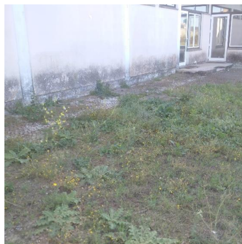
Zona de circulação a recuperar
