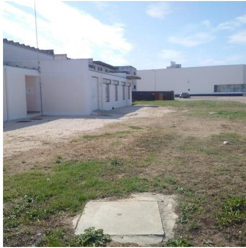
Zona a pavimentar
